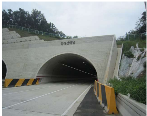
1공구 성라산터널(서울) 종점부
