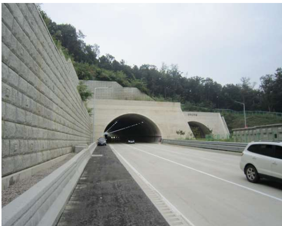
1공구 성라산터널(서울) 시점부
