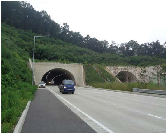
3공구 견달산터널(서울) 시점부
