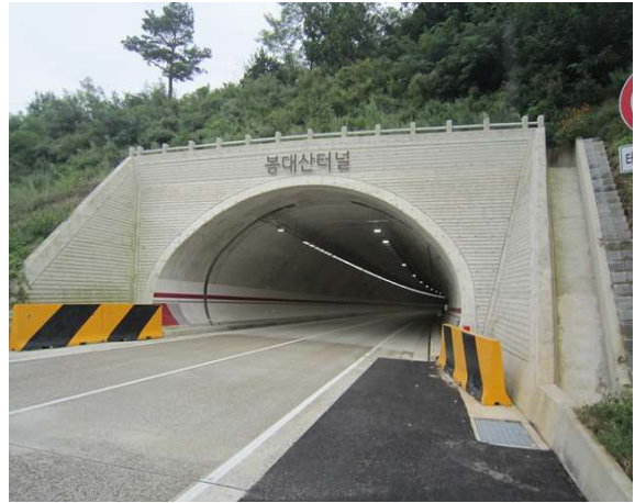
1공구 봉대산터널(서울) 종점부
