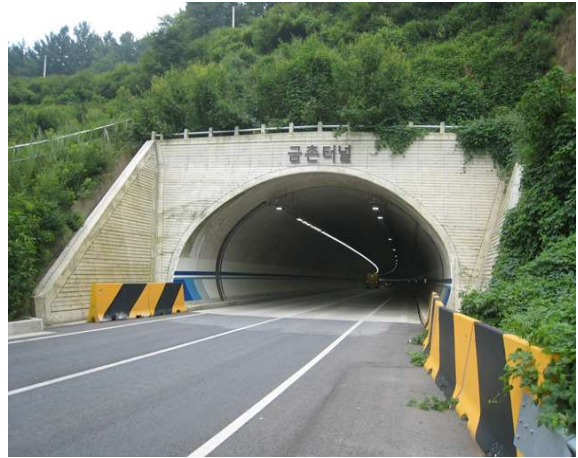
4공구 금촌터널(서울) 종점부
