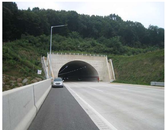
3공구 견달산터널(문산) 종점부
