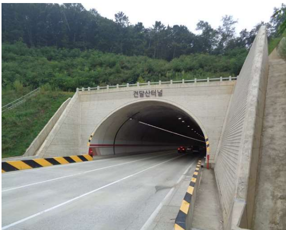
3공구 견달산터널(문산) 시점부
