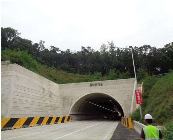
1공구 성라산터널(문산) 시점부
