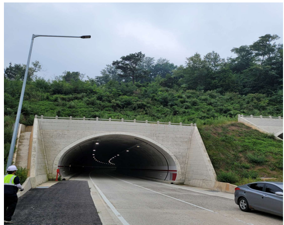
1공구 봉대산터널(문산) 종점부
