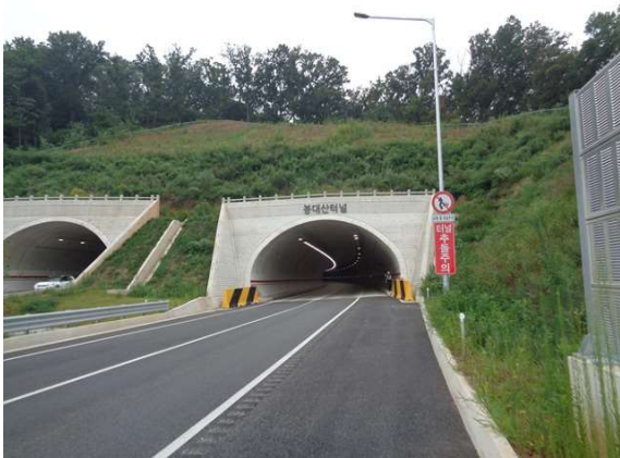
1공구 봉대산터널(문산) 시점부
