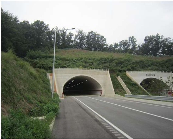
1공구 봉대산터널(서울) 시점부
