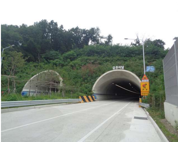
4공구 금촌터널(문산) 시점부
