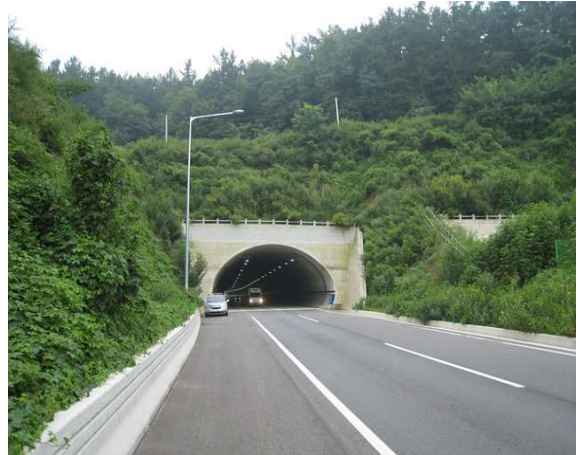
4공구 금촌터널(문산) 종점부
