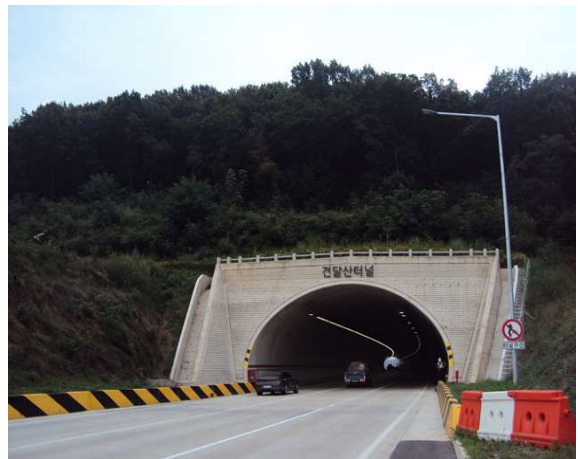
3공구 견달산터널(서울) 종점부
